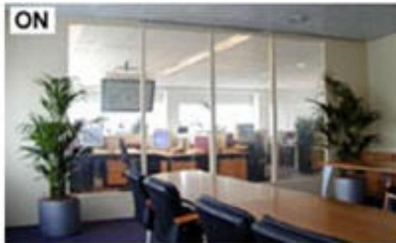
Ces vitrages adaptent leur transmission lumineuse de la lumière sous l'effet d'une impulsion électrique.
